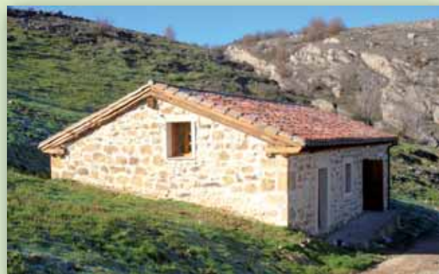
Edificio que alberga el Centro de Interpretación. Carlos González
